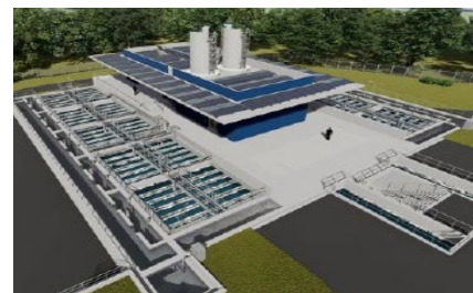
Visualisierung der Anlage zur Elimination von Mikroverunreinigungen.
