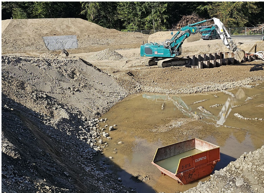
Baubeginn für die Erneuerung der ARA Buholz in Emmen LU.
