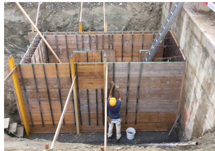
Ausbau des Regenfangbeckens Tobel
