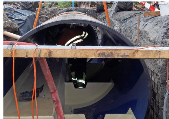
Der maximale Ausbau des bestehenden Durchlasses wurde auf 1.8 Meter Durchmesser erhöht, was jedoch die Gefährdung für die benachbarten Häuser noch nicht wegnimmt. Aus diesem Grund wurde von Kuster+Hager AG Filiale Wetzikon ein zusätzlicher Bypass vorgeschlagen und realisiert. Das rund 100 Meter lange Rohr mit einem Durchmesser von einem Meter sorgt bei Hochwasser für die erforderliche Wasserabnahme, bei normalem Wasserstand fliesst das Wasser durch den neuen Durchlass.
