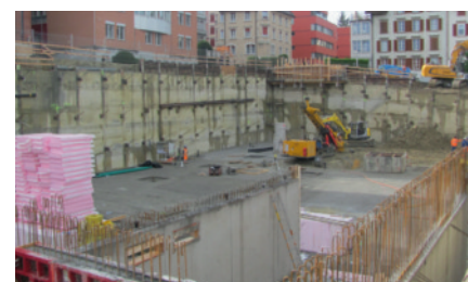
Riesige Baugrube mitten im Zentrum
