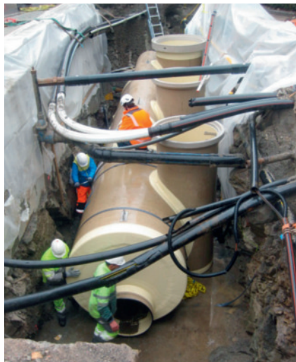
Montage des Hobas CSO Chamber mitten in Pfäffikon.
