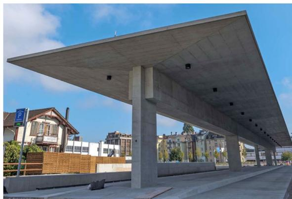
**Der Bushof über der Tiefgarage mit filigraner Sichtbetonkonstruktion.**
