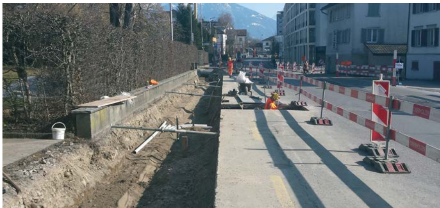
Werkleitungen und Kanalisation werden in die Zürcherstrasse auch in Nachtschicht (siehe unten) eingebaut.
