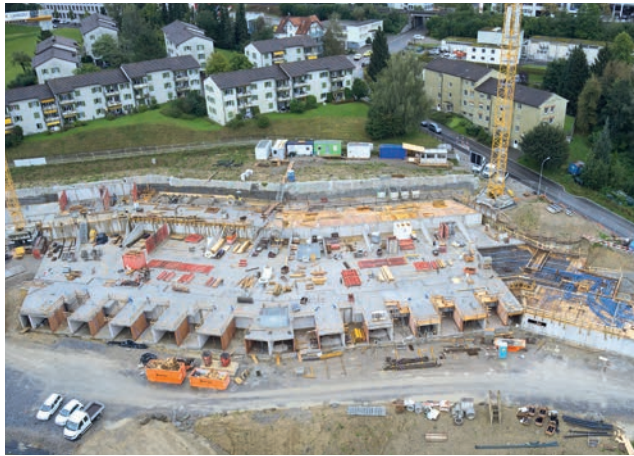
Die Baugrube Waldacker in St.Gallen
