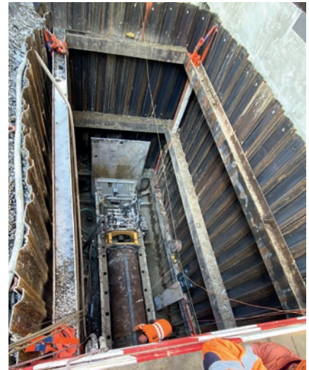
Vorantrieb des Stahlrohres
