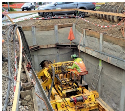
Pressbohrungen unter dem Bahngleise
