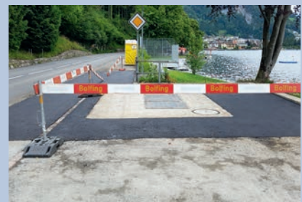
Die im Erdreich versteckte Pumpstation
