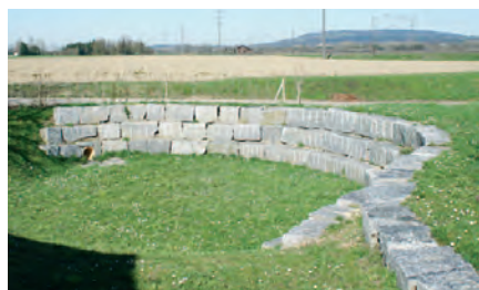
Ein Teil der Strassenentwässerung erfolgt über Versickerungsbecken.
