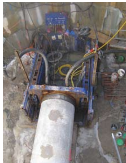
Installation Microtunnelling-Vortriebseinrichtung im Startschacht mit 9 m Ø in 8 m Tiefe.
