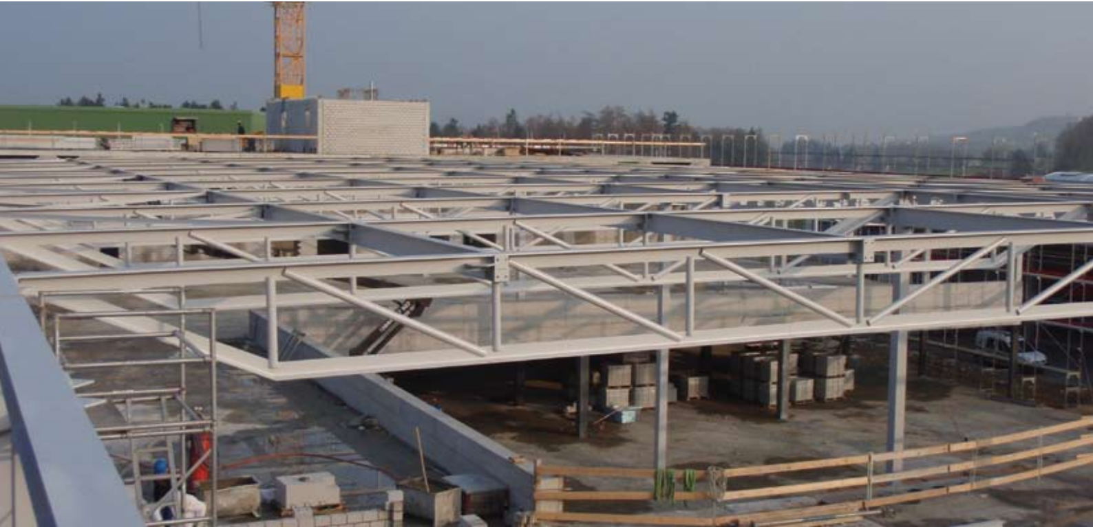
Stahlskelettbau für die Grosswäscherei Bernet in Bronschhofen
