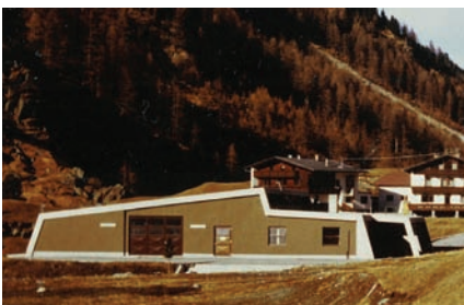
Überdachung der Kläranlage Gurgel
