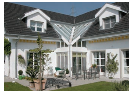
Einfamilienhaus mit Wintergarten
