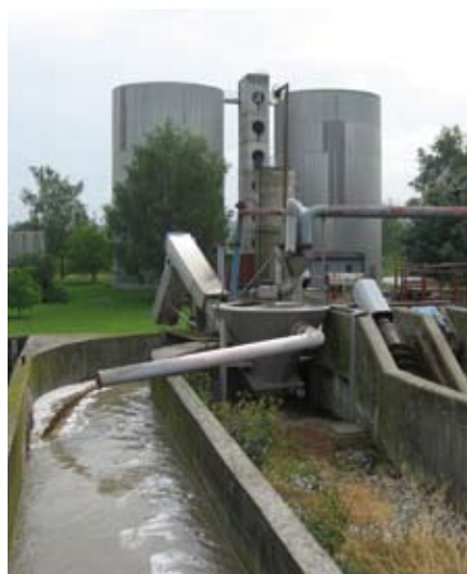
Alte Kläranlage in Ptuj
