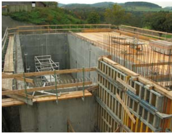
Das Wasserreservoir Bühl wird mit zwei Kammern gebaut.
