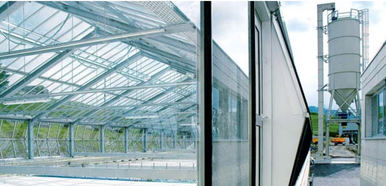
Die Klärschlamm-trocknungsanlage Einsiedeln mit dem Siloturm für Klärschlammgranulat zu Heizzwecken
