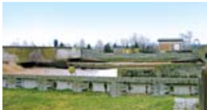
Die alte Kläranlage
