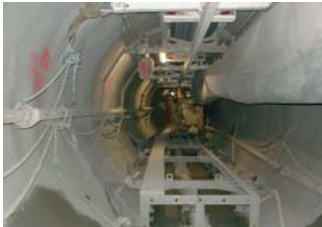
Vorantrieb des Entlastungstollens unter dem Industrieareal in Uzwil
