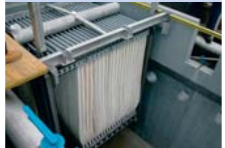
Mit Membran-Spaghettis werden Bakterien und Viren filtriert
