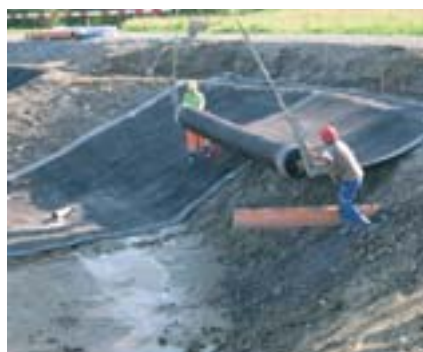
Mit Bentonitmatten werden die Öko-Filteranlagen abgedichtet.
