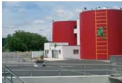
Blick auf die Abwasserreinigungsanlage Bad Zurzach
