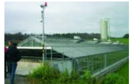
Einsiedeln baut eine Klärschlamm-Trocknungsanlage wie in Sulz (D).
