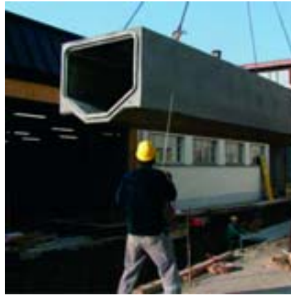
Fertig vorfabrizierte Elemente für den Abwasserkanal.
