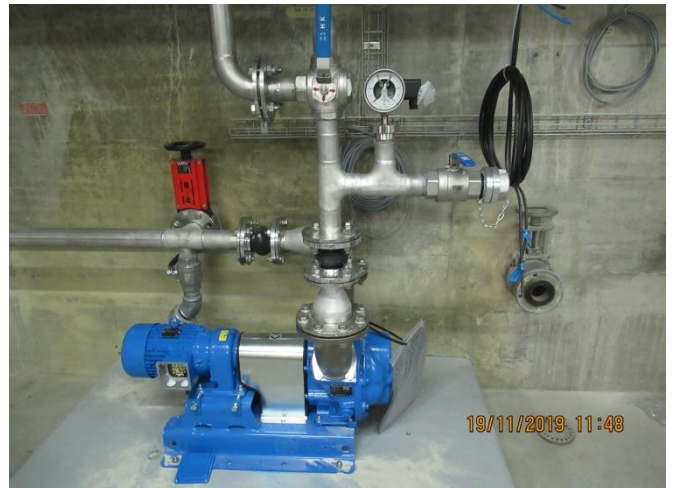
Pumpe Schlammmentwässerung
