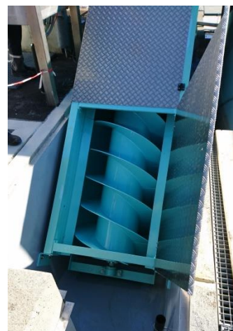
Schneckenhebewerk
